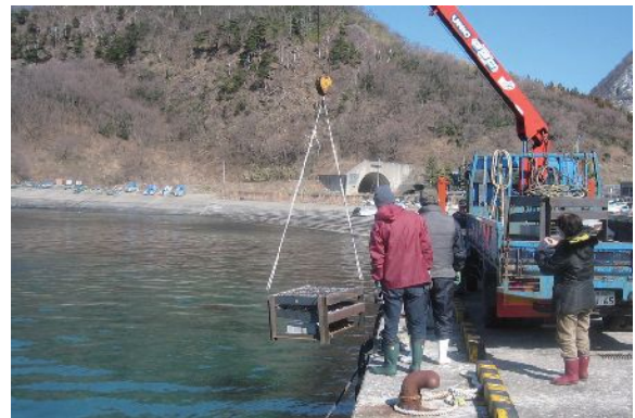
▲増殖施設の沈設作業
