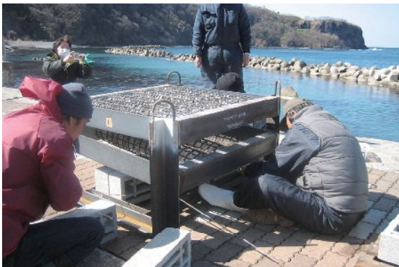
▲増殖施設の組立作業
