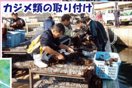
漁業者による設置作業
