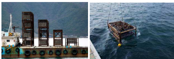
図 1 港湾施設に設置された貝殻構造物 (左: 敦賀港、右: 大島漁港)
