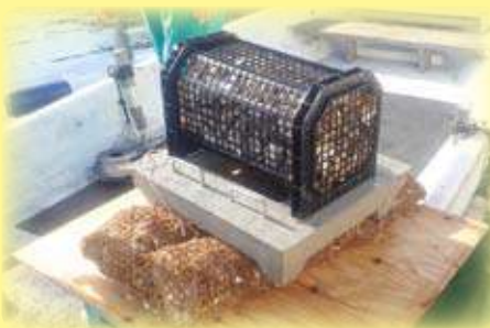
④貝藻くんを載せて 細いロープで固定
