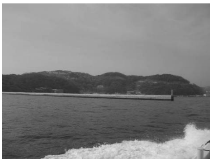
写真-1 兵庫県姫路市家島東防波堤
